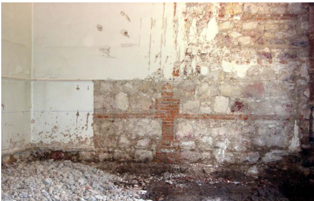
13: Escuela Normal de Zamora. Muro de fábrica mixta de mampostería y verdugadas de ladrillo.
