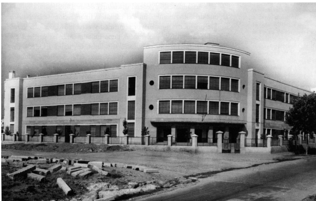
12: Vista de la Escuela Normal de Zamora tomada poco tiempo después de su entrada en servicio.
