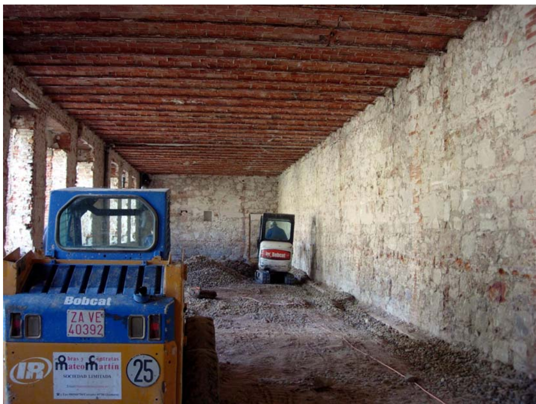
17: Escuela Normal de Zamora. Vista del ala occidental de la planta baja en fase de rehabilitación.
