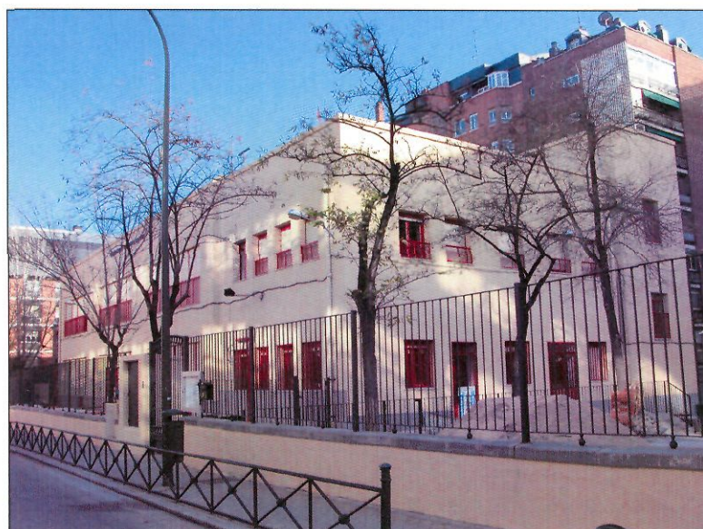
334-335: Grupo escolar de Chamartín de la Rosa (Madrid). Estado actual.
