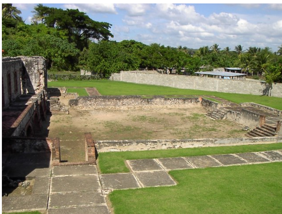
Vista lateral de la casa de calderas
