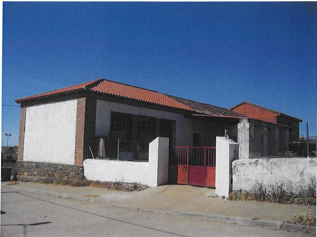
Escuela reformada de Aldeanueva de la Sierra (1938). Salamanca. Fachada delantera.
