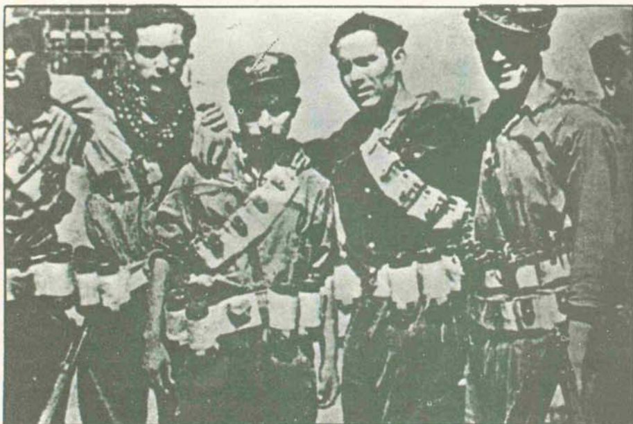
Durante el desarrollo de la lucha en Aragón, los grandes propietarios huiran despavoridos ante el demoledor avance de la «Columna Durruti», que aplastaba todo foco de resistencia que encontraba a su paso. En la foto, varios dinamiteros confederales, que tuvieron una gran participación en el curso de las batallas libradas en este frente.
