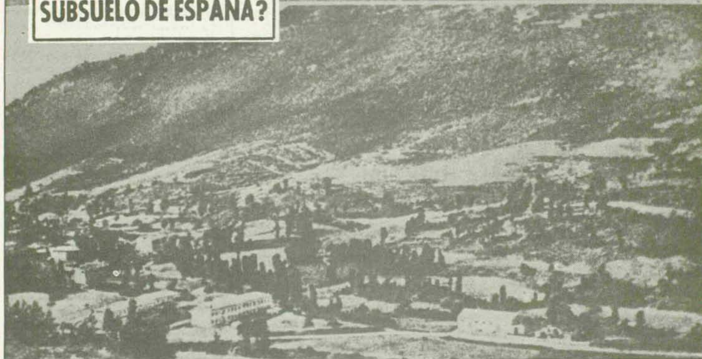
Vista parcial del valle desde el lugar mismo en que actualmente se practica un sondeo. En la parte derecha de la fotografía, puede verse el almacén de material, junto a la carretera, más a la izquierda, los dos grupos de viviendas construido, y un poco más al fondo, las casas del pueblo de Villanueva de Rampaláy.
