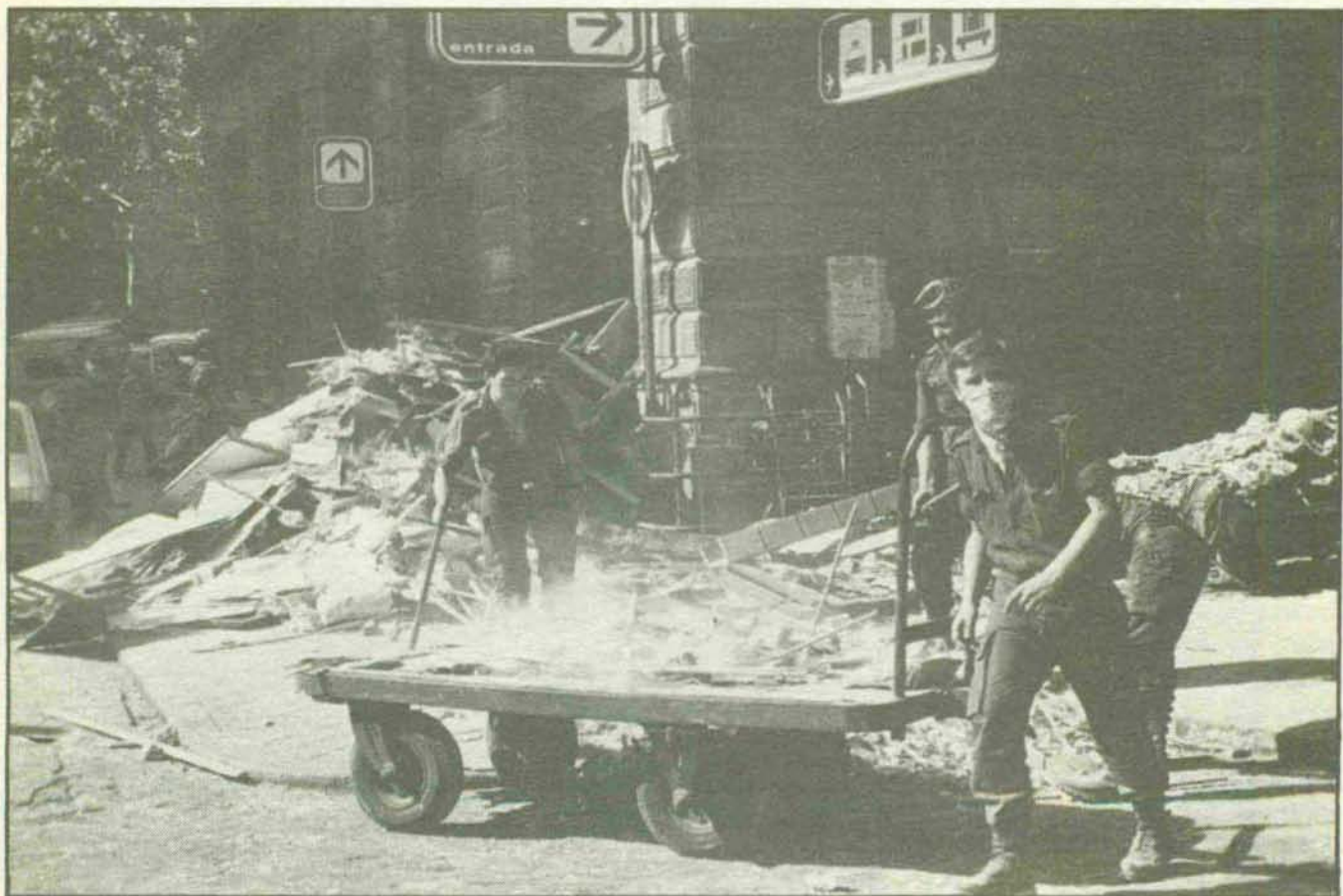
Destrozos causados por un artefacto en el vestíbulo de la estación de ferrocarril de Atocha, de Madrid, en julio de 1979, causando cinco muertos y varios heridos.
