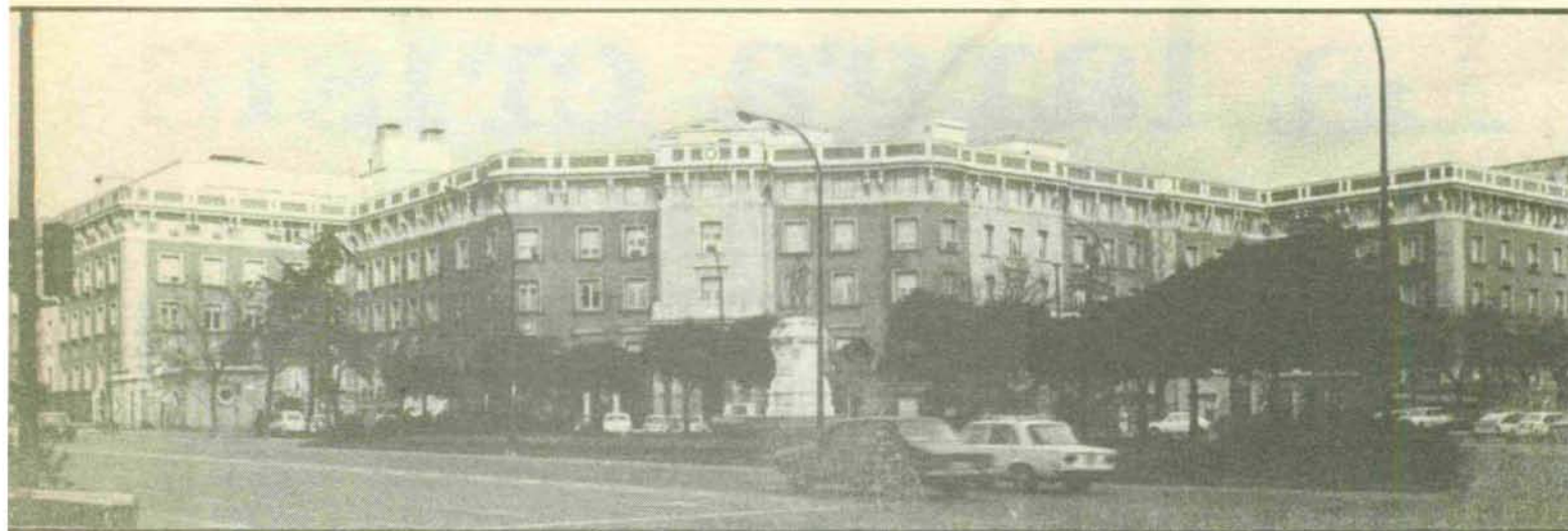
El edificio del INI (Instituto Nacional de Industria), en Madrid.
