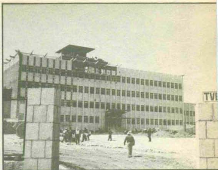
La construcción del nuevo edificio de Televisión Española, en Prado del Rey, a comienzos de la década de los sesenta.
