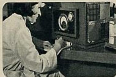
Los tejidos son jabonados y lavados en frío y caliente y después sometidos a corrientes de aire a distintas temperaturas para medir su velocidad de secado.
