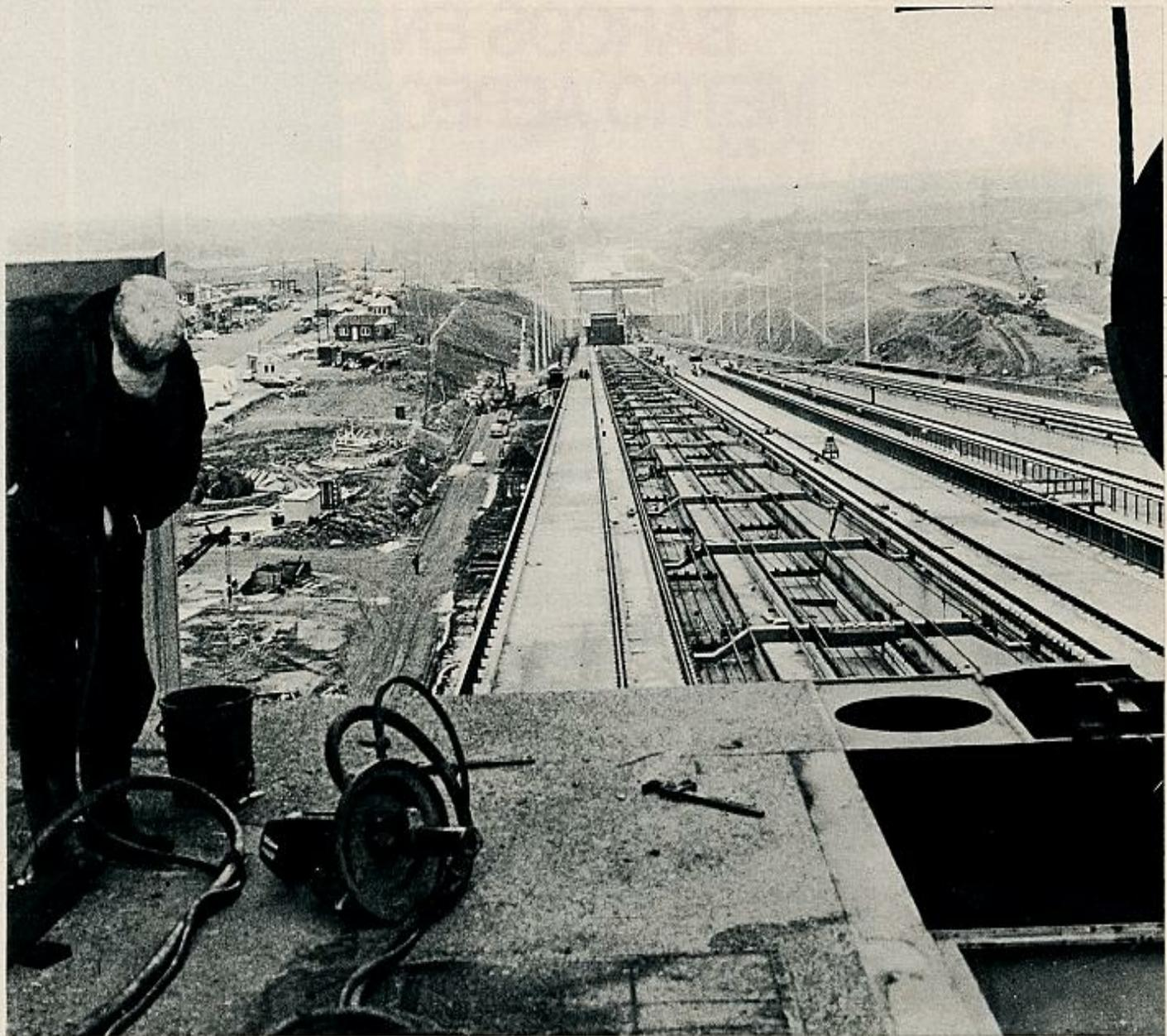
El plano inclinado de Ronquières durante las obras. Sobre las vías se deslizan las balsas llenas de agua que transportarán a los barcos, salvando el desnivel del canal.
