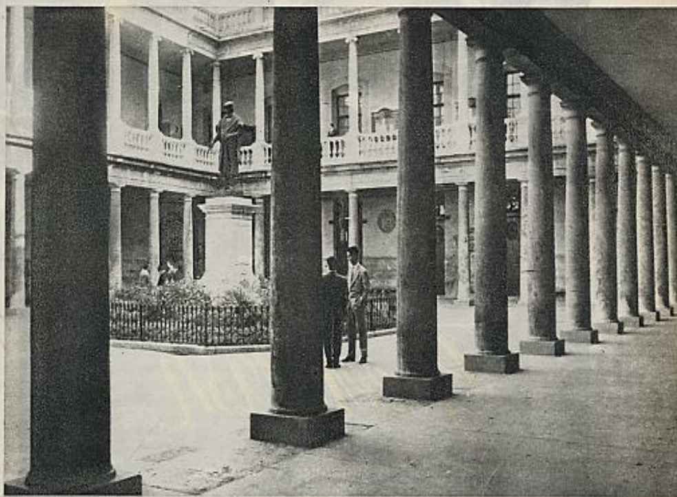
La Universidad valenciana ha crecido y sigue creciendo, ciudad afuera, en nuevos edificios para las Facultades, las Escuelas Especiales, los laboratorios y los Colegios Mayores. En tanto, este armonioso claustro que preside la efigie de Juan Luis Vives, permanece como testimonio de la continuidad de una institución por la que desfilaron ya incontables generaciones. A dos pasos, el claustro, más admirable todavía, del Colegio de Corpus Christi, con su incalculable tesoro artístico y su fuerte severidad litúrgica...
