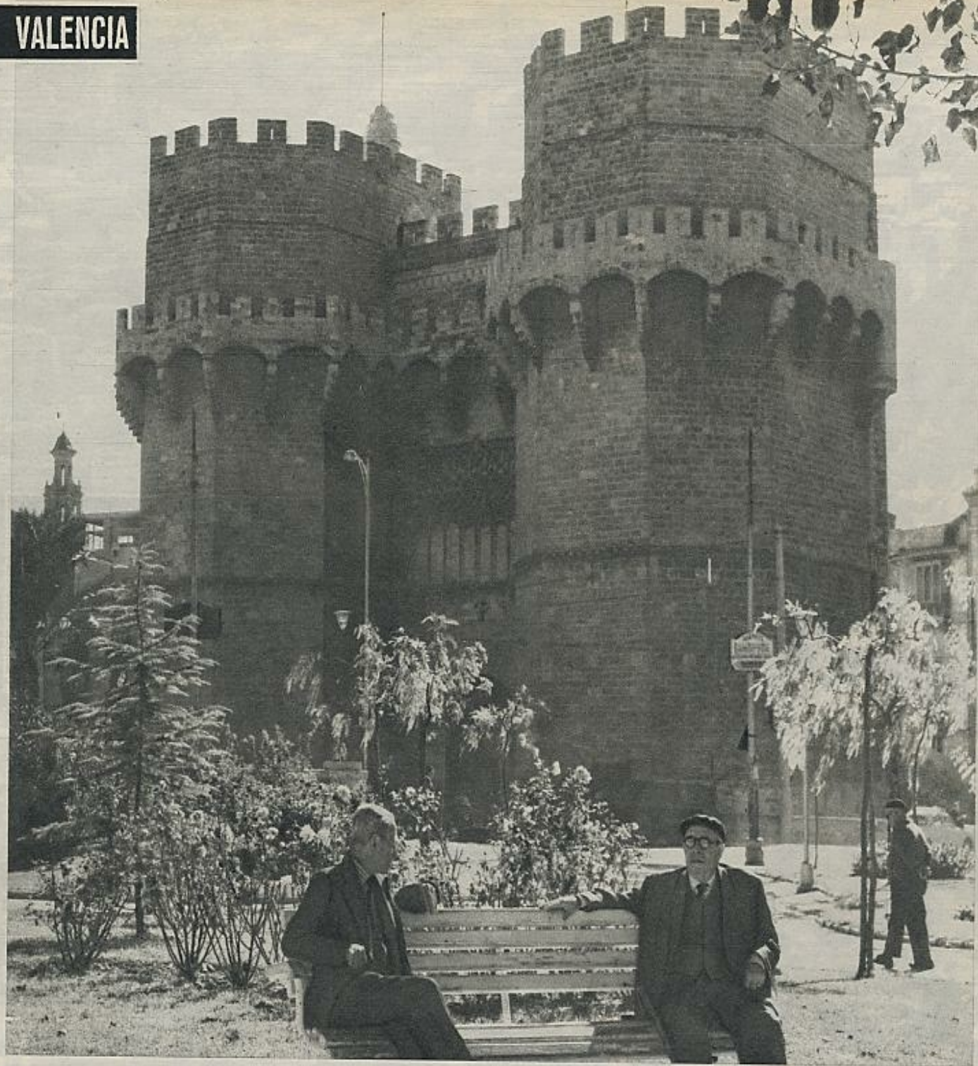
Estas son las Torres de Serranos, sobre cuyos rubios sillares baten los cierzos del norte. Puerta abierta al que llegaba antaño a la ciudad, ya que Valencia fue siempre solar de arraigo para gentes de otras comarcas. Las construyó Pere Balanguer avanzada la Edad Media y, al terminarlas, quedaron tan satisfechos los jurados de la ciudad, que le regalaron un corte de rica tela de Flandes. Son una bellísima creación del gótico valenciano, admirable por sus sabias y armoniosas proporciones.
