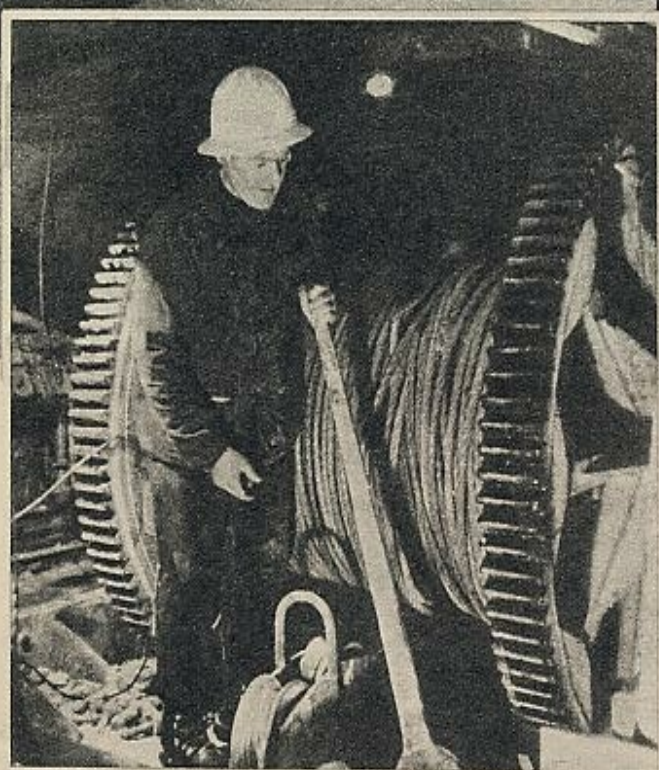
Un obrero revisa los imponentes cables que sorportarán el peso del ascensor
