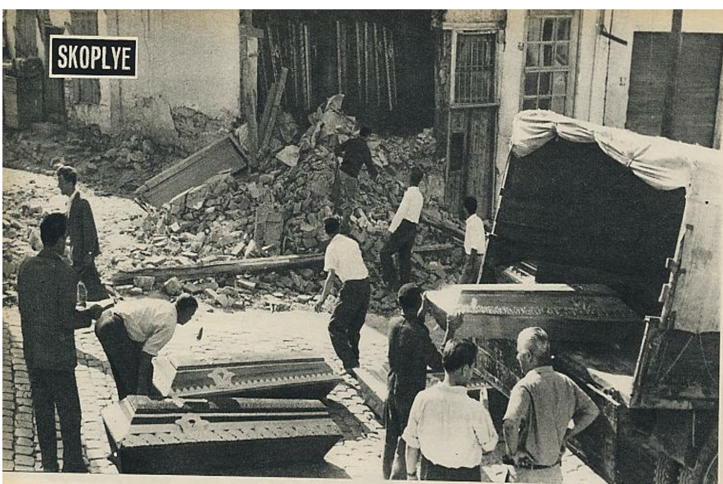
El edificio donde se hallaba establecida una funeraria se ha derrumbado. Entre sus ruinas son rescatados los ataúdes que habrá que utilizar con urgencia.
