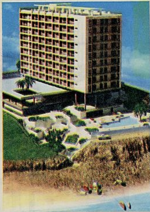
Apartotel Torremar, que construye Promotora Meliá en Torremolinos
