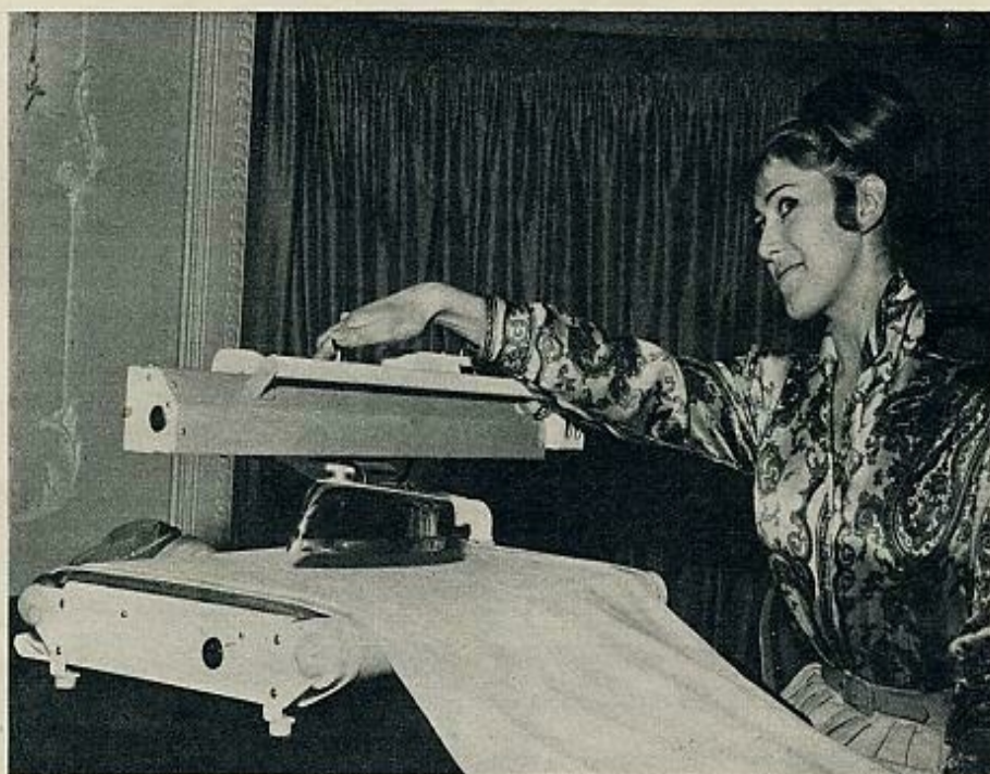
Plancha automática que descansa sobre una tela que funciona como correa sin fin. Cuando se planchan piezas grandes, la plancha se mueve al mismo tiempo que la tela efectúa un movimiento de rotación. Cuando las prendas son pequeñas, la tela permanece quieta y es sólo la plancha la que se mueve.
