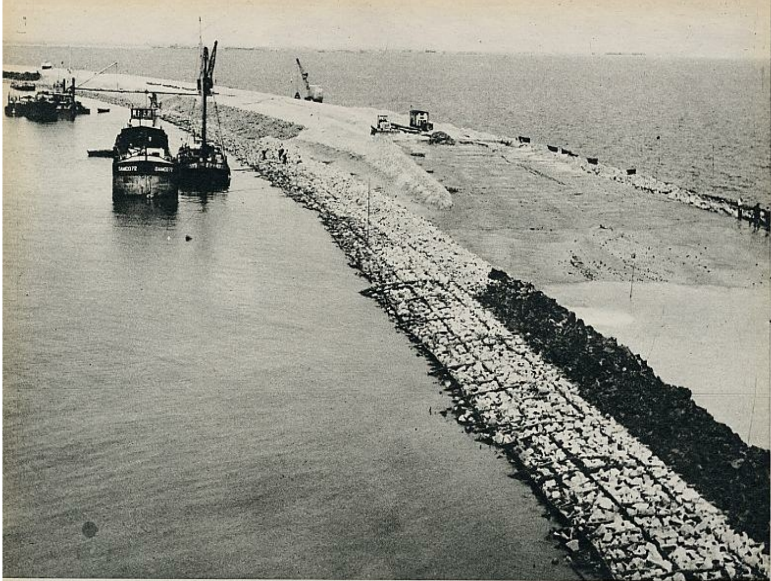
Sobre el texto, foto de la izquierda, la construcción del dique de cierre del nuevo polder del sur de Flevoland, en el IJsselmer: el barro es dragado del fondo del mar y re construcción de un conjunto de compuertas para el dique de Haringvliet, proyecto Delta. Una pequeña isla es protegida por un dique y dejada en seco. Allí, en terre
