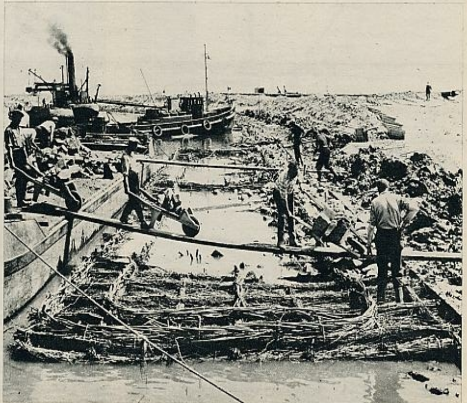
emplazado con arena. Las capas de junco cubiertas con piedras —foto de la derecha— protegerán el dique de cierre del nuevo polder. Bajo el texto, en las tres fotos, no firme, sobre el fondo del mar, se construyen las compuertas: después se desplaza la isla y se construye el dique. Ardua tarea de la cual depende la seguridad del país.
