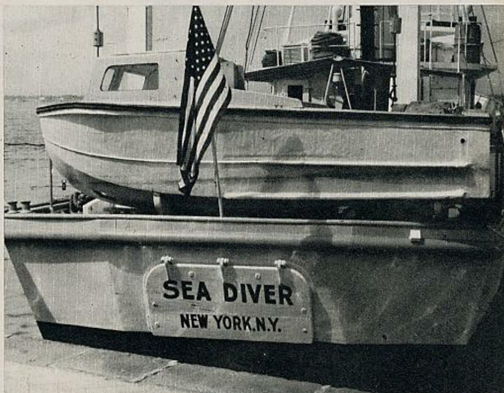
El «Sea Diver» va provisto de un pequeño barco auxiliar, propulsado a reacción, a fin de evitar los peligros de la hélice y los cables de remolque. En él hay un generador, un compresor y dos escafandras.
