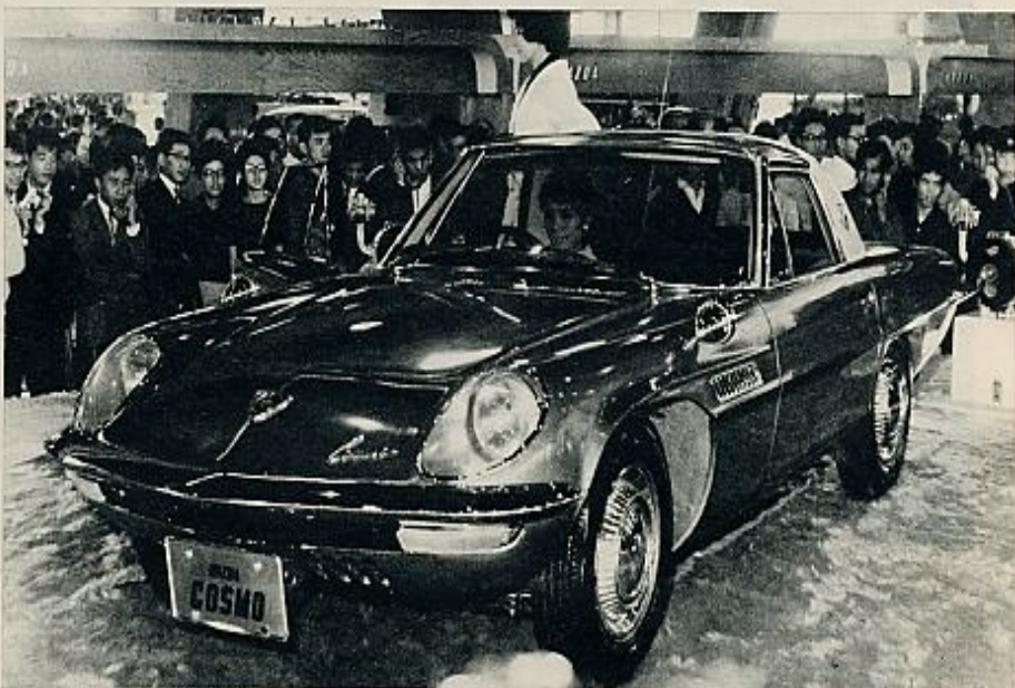
El «Mazda Cosmo», que está provisto de un motor de 800 c.c., y de 70 H. P. Es un ensayo de coche deportivo en el que se han introducido el motor rotativo Wankel, de acuerdo con la prestigiosa firma alemana NSU.
