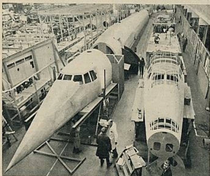
Noventa mil millones de pesetas se invirtieron en el proyecto «X-B 70 A». El primer vuelo no fue muy afortunado, aunque posteriormente se hayan perfeccionado todos los detalles gracias a numerosos vuelos de pruebas. Abajo, el modelo en madera del «Concorde», el avión franco-británico que ha de competir con el americano.
