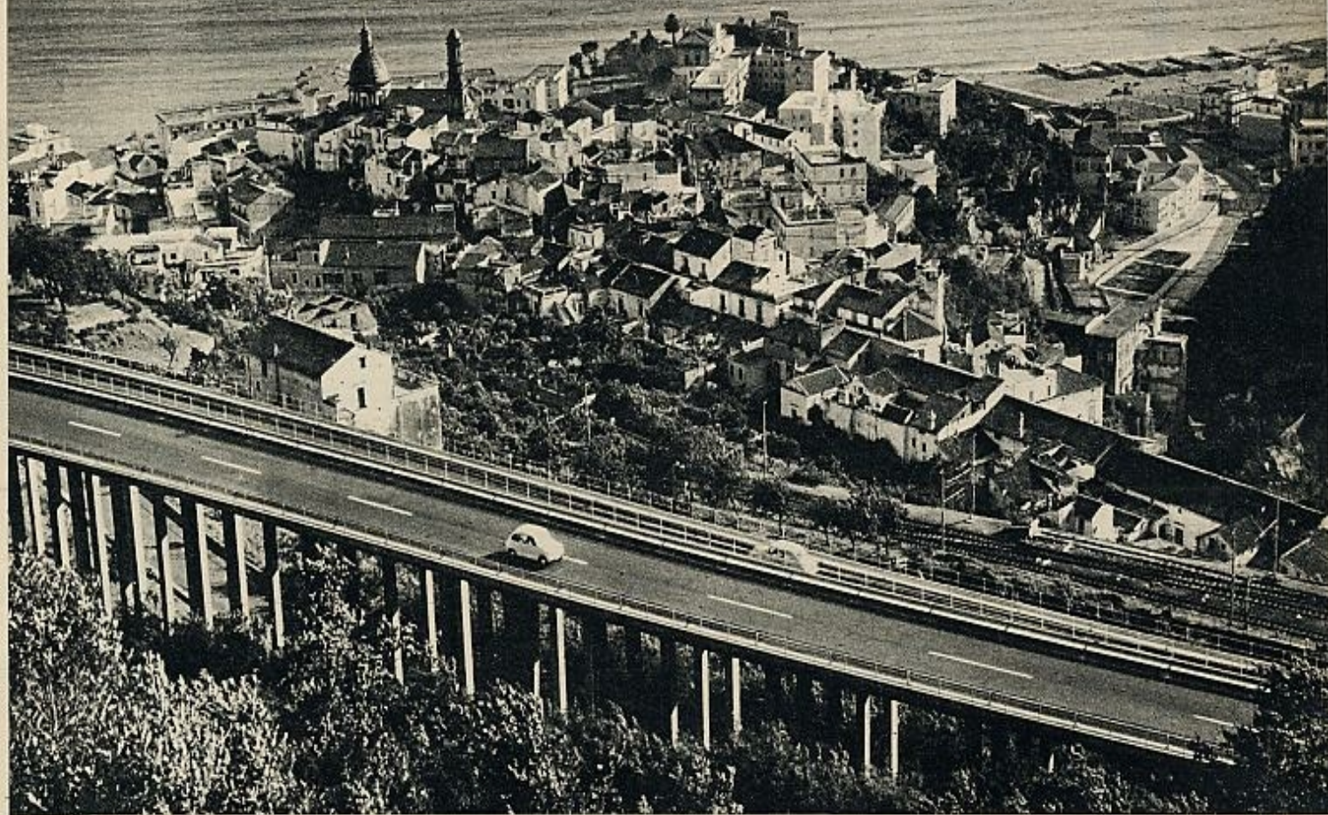
Frente a Salerno cruza la «Autostrada» sobre un puente hecho de puntales. Abajo, una visión nocturna de la vía automovilística a su paso por Milán.
