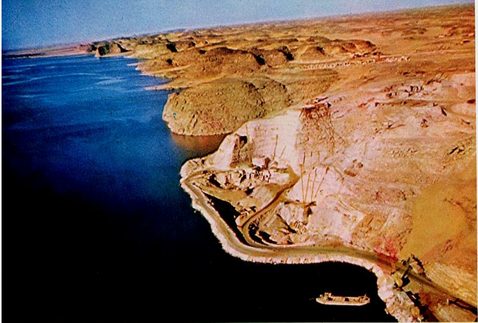
Vista aérea de los trabajos de traslado. Las aguas del Nilo, en época de crecida, están a punto de saltar sobre la presa protectora. Sobre el acantilado superior se reconstruirán los templos de Abu Simbel, en un lugar adonde no podrán llegar jamás las aguas del padre Nilo en su crecidas periódicas. Abajo, bloques del templo.
