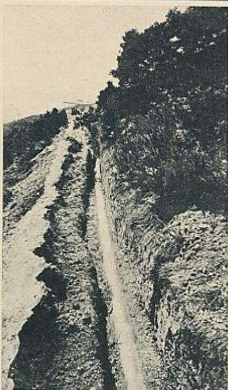
Gracias al fácil manejo y rapidez de instalación de los tubos de Glassidur PVC, fabricados por Formica Española, S. A., se ha conseguido en veinticinco días montar la tubería de conducción de aguas potables de Venta Alta a Basauri (Vizcaya). En esta conducción existen 6 sifones, el tubo es de 250 mm. Ø y está sometido a presiones de 4, 6 y 10 atmósferas.
