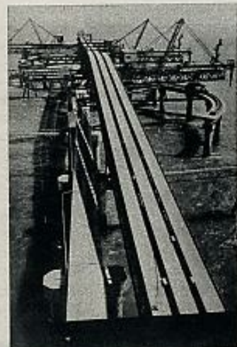
Banda transportadora que une la mina de fosfatos en Bueraa con el puerto de El Aaiún.
