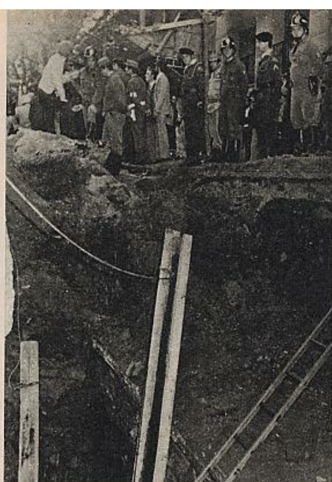
TRABAJOS EN EL TUNEL DESCUBIERTO EN BARCELONA. —Militares, bomberos, policía y otros técnicos estudian la situación de los trabajos de apertura del túnel. La profundidad de la zanja abierta da una idea clara del trabajo realizado por los autores del túnel fabricado.
