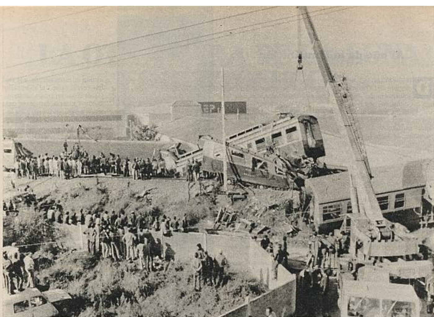
Vista panorámica del lugar donde se produjo el accidente, con los dos convoyes incrustados entre sí.
