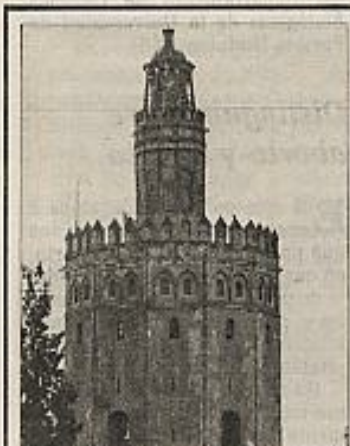
Torre del Oro, Sevilla.
