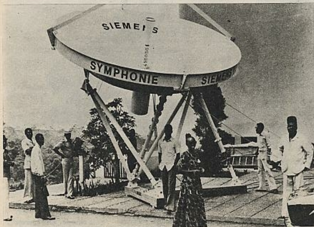
Estación destinada a captar y retransmitir los programas de televisión recibidos vía satélite, en Kigali, capital de Ruanda.
