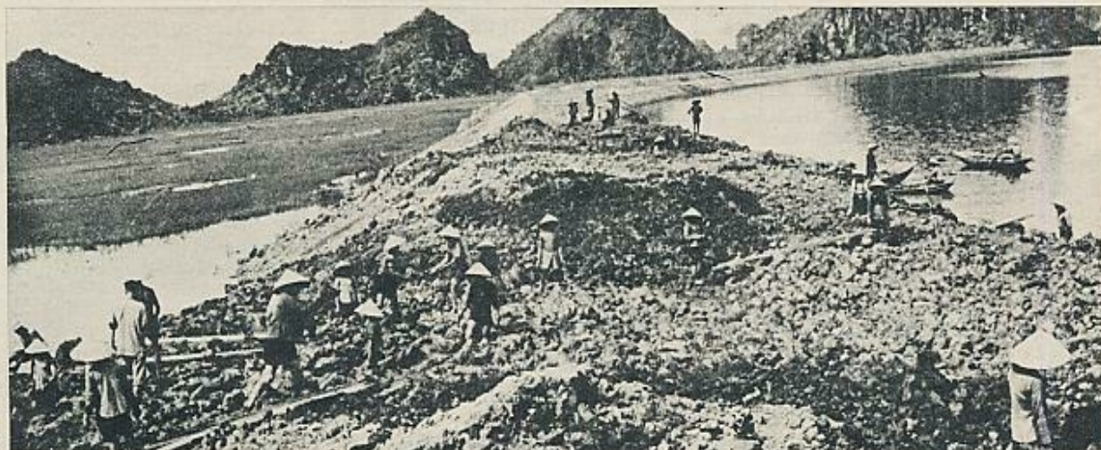
Obras provisionales de contención de aguas en Vietnam del Norte.
