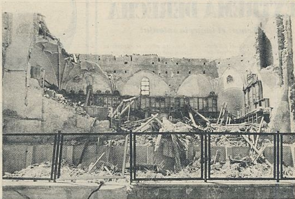
La Capilla de los Estudios de Cerbuna, tras el hundimiento.
