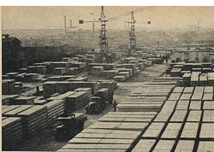
Una imagen del desarrollo industrial de China: elementos de construcción prefabricados.
