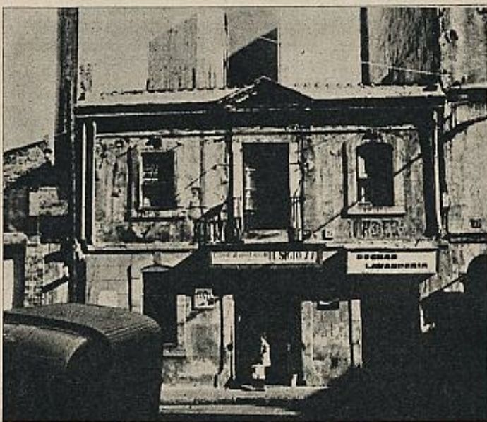
Una de las pocas construcciones de dos plantas que se conservan tal como fueron concebidas en el siglo XVIII.
