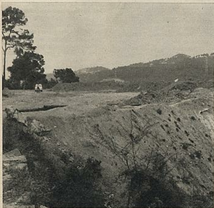
Parte del solar formado por los vertidos de tierras efectuados por la empresa que realiza las excavaciones de los futuros túneles de Vallvidriera. Como se puede ver en la imagen, la vegetación natural del bosque —pinos, robles, encinas y sotobosque— ha sido sepultada por las tierras. Así se ha rellenado la vaguada conocida como «Camí de les nespreres», con lo que se ha dado lugar a una formación llana. (Foto: Pablo Morata.)
