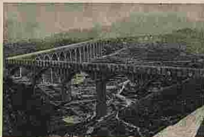
Vista del canal Shiangtung, de 45 kilómetros de longitud, que cruza los distritos de Yunshao y Yungshan, en la provincia de Fochien. Este canal, construido en dos años durante la Revolución Cultural, está montado sobre puentes de doble curvatura.
