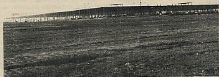
Estado de las obras de la factoría Ford en enero de este año.
