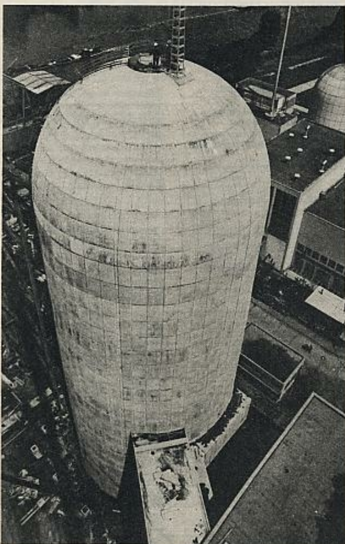
Los residuos de los reactores nucleares son peligrosos durante siglos.
