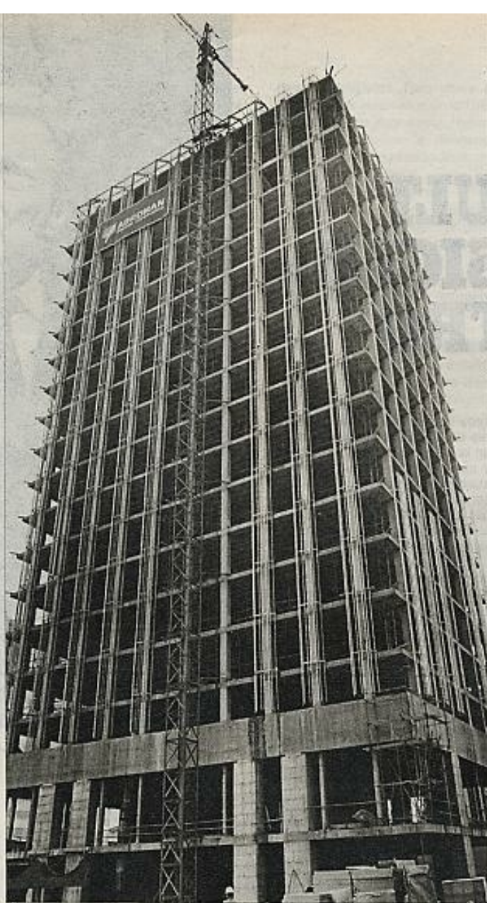
Una manera sencilla e interesante de aprovechar la energía solar es utilizarla para la calefacción, refrigeración y agua caliente. Sobre estas líneas, edificio en construcción en el conjunto AZCA, de Madrid, que se nutrirá de energía solar para su sistema de aire acondicionado y calefacción.
