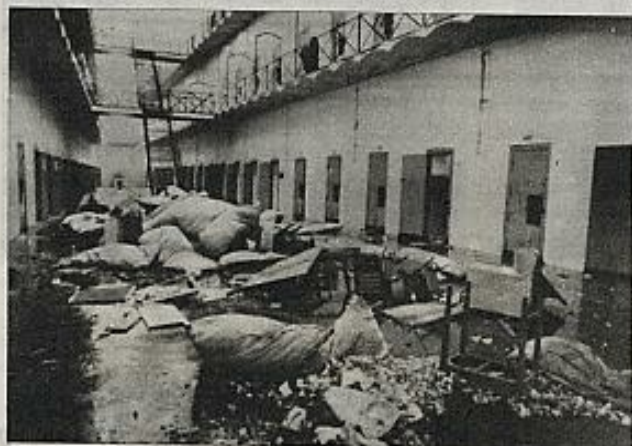
Estado en que quedó la cárcel modelo de Valencia tras el reciente motin de los reclusos.
