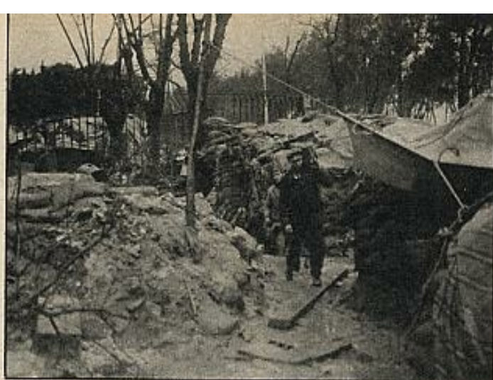
Trincheras abiertas en la plaza de la Moncloa.
