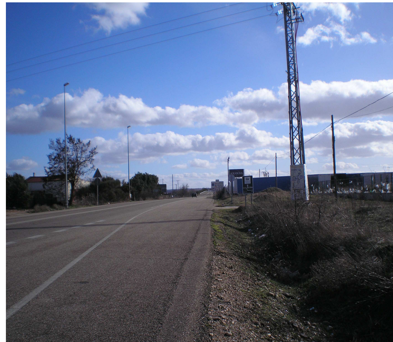
Imagen en el P.K 0+280. Tendido eléctrico
