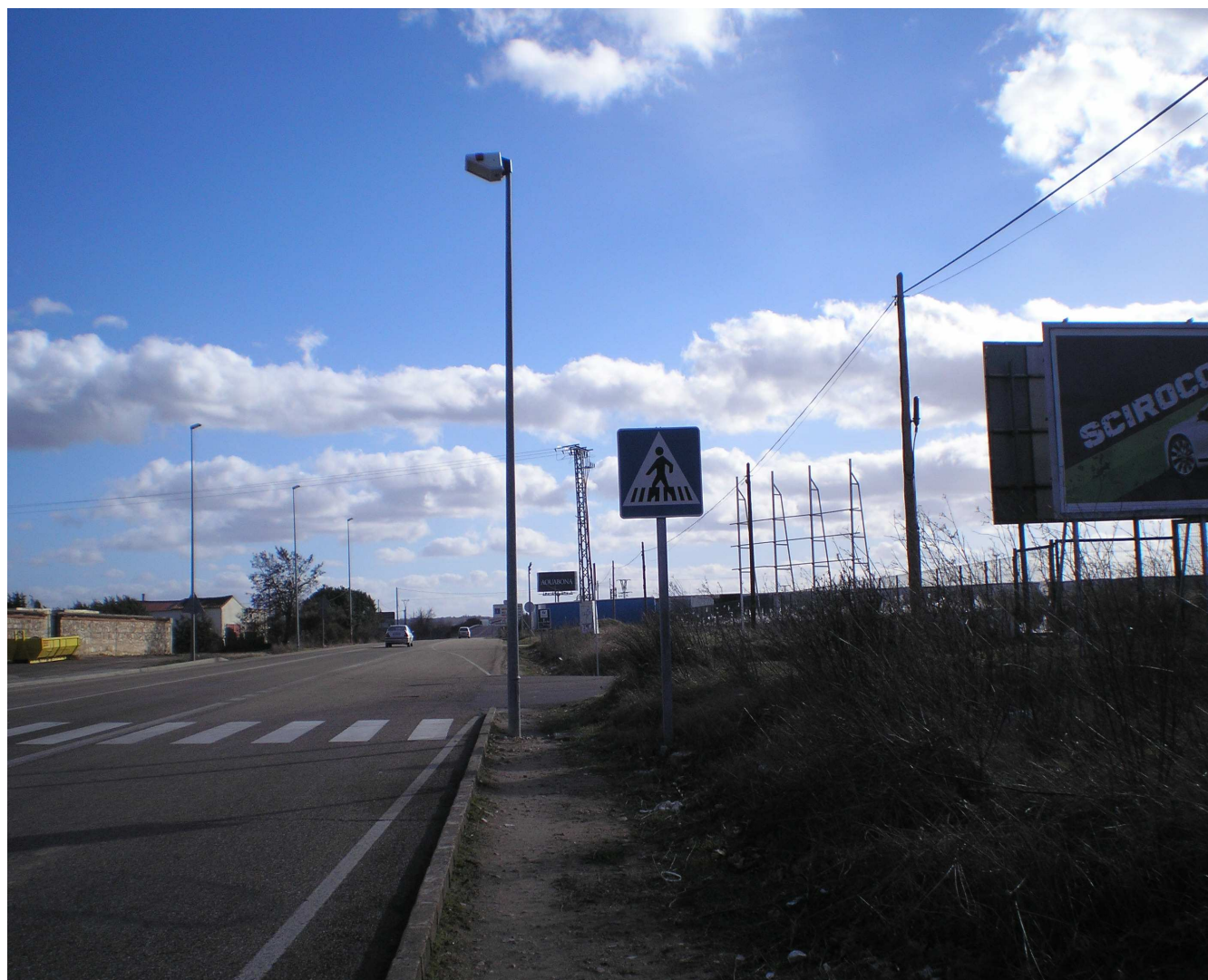
Imagen en el P.K 0+200. Servicios existentes en la zona
