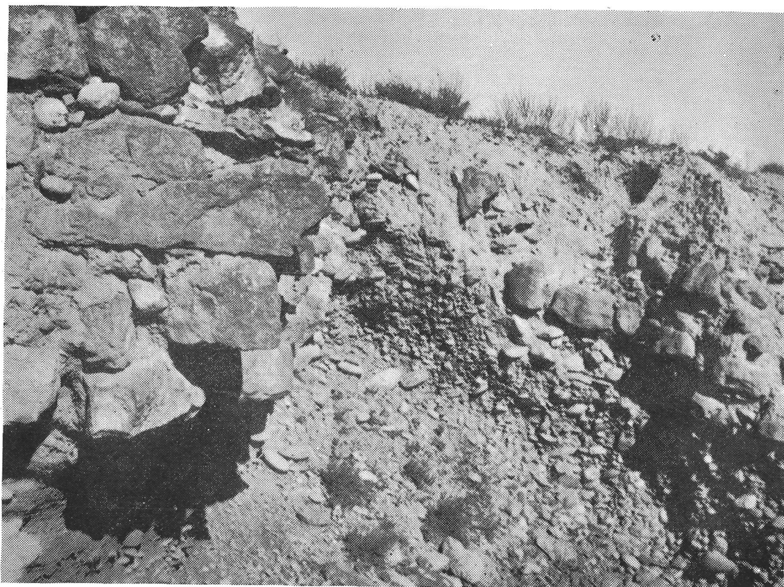
Vista de la zona-isla liberada de los trabajos. (Obsérvese la obligada reducción del área de la cata para seguridad de los trabajadores)
