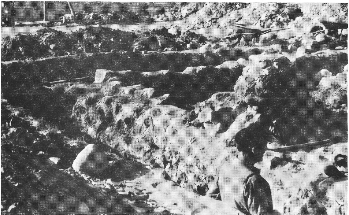
Comenzando la excavación en la zona reservada para efectuar la cata estratigráfica y construcciones del «habitat» correspondiente al plano del estrato I (Cf. fig. 7)
