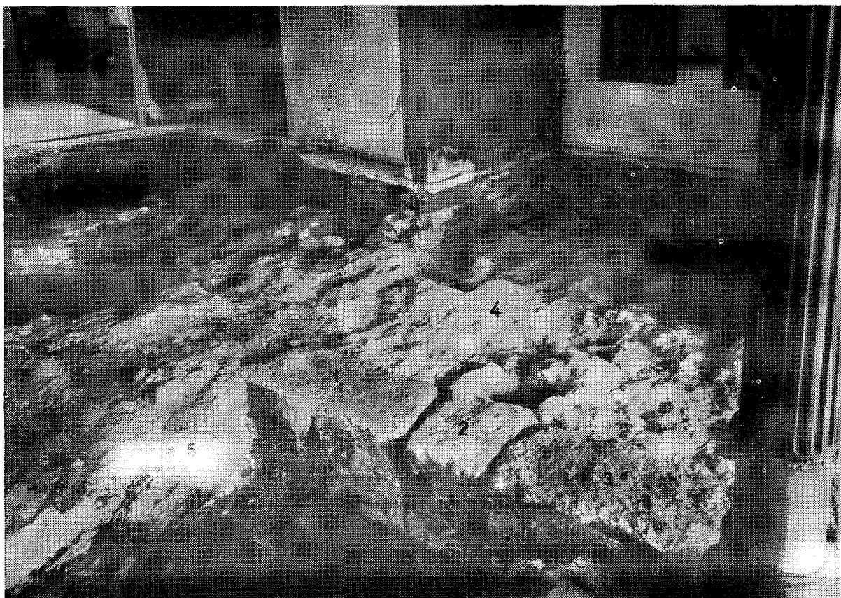
Excavación de la torre n.º 8 ó de Diana, bajo la casa n.º 37 de la calle de la Tapinería, el día 24 de febrero de 1959. Levantado el pavimento moderno, aparece el macizo de la torre y los sillares que la revisten; 1, 2 y 3, sillares del revestimiento exterior que numeramos para identificarlos en las fotografías siguientes; 4, hormigón que forma el macizo interior de la torre; 5 macizo interior de la muralla al que faltaban ya los sillares del revestimiento; 6, muralla interior de piedras irregulares
