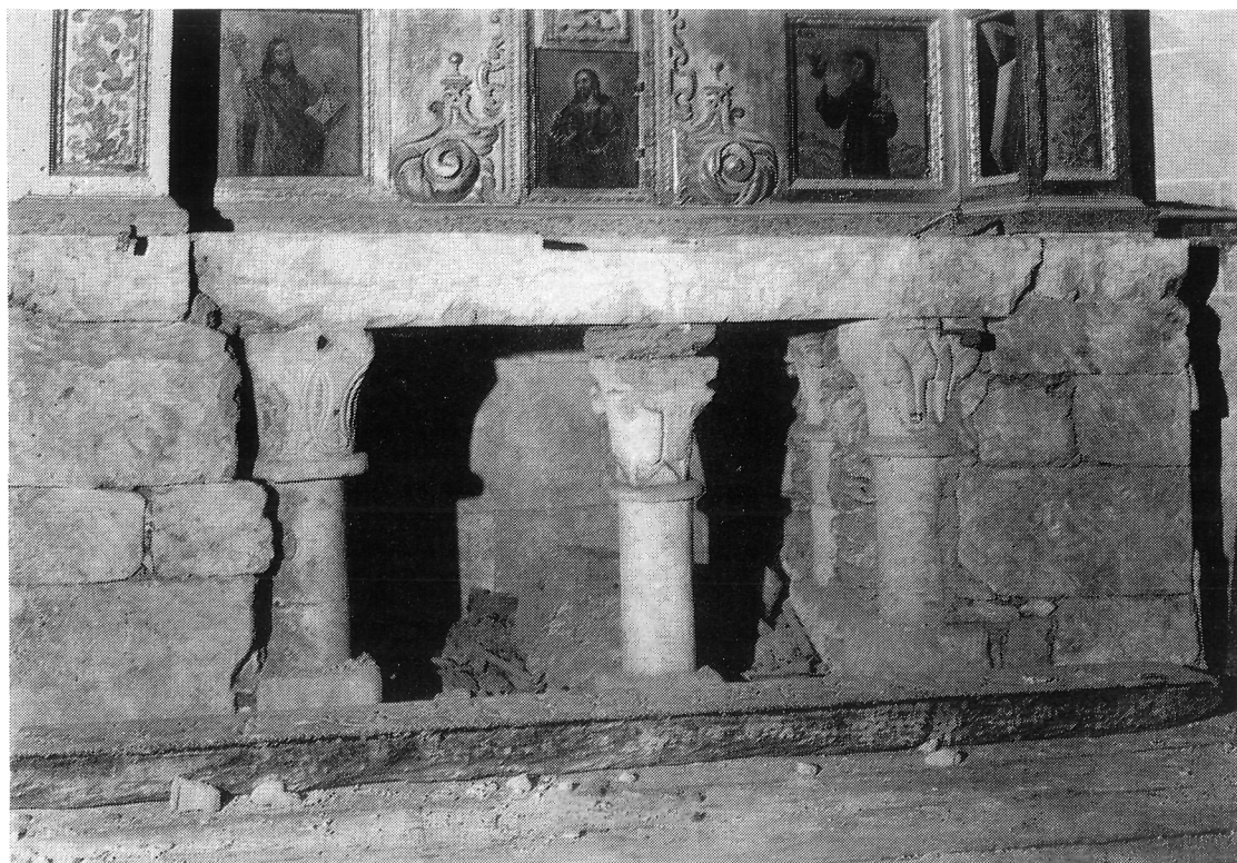
Altar románico sobre conco columnillas con capiteles vegetales descubierto tras un frontal barroco de 1678 en el ábside del lado derecho.
