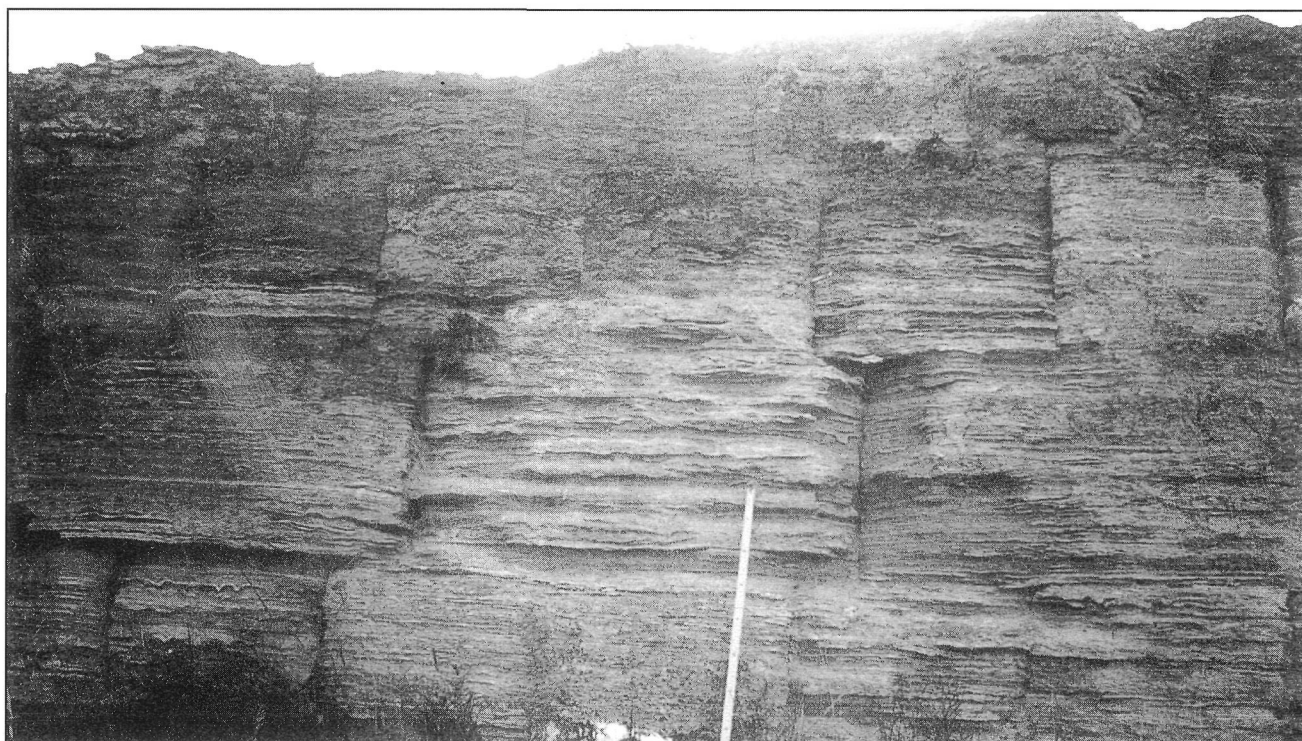
Figura 3-2: Detalle del alzado de la cara Norte de la muralla de sillares de yeso de «El Durón» de Belmonte. Obsérvese el aparejo regular a soga y tizón.
