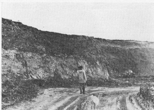
Figura 2.—Vista general del espejo de la falla núm. 1.
