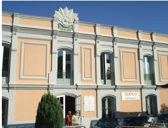
Ilustración 87 Fachada del Antiguo Balneario de Baños de Montemayor
