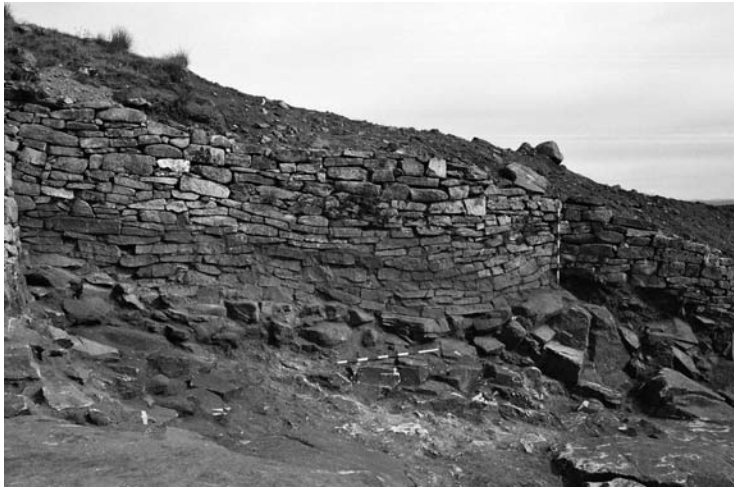
FIG. 11. Tramo de lienzo rectificado (derecha) montado sobre escombros.
