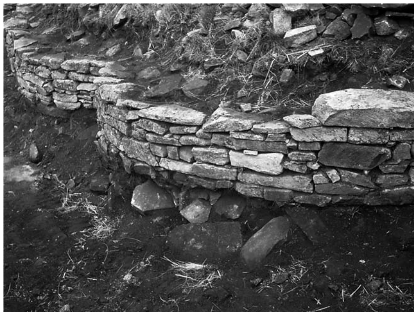
FIG. 8. Cimentación de la reparación del bastión.
