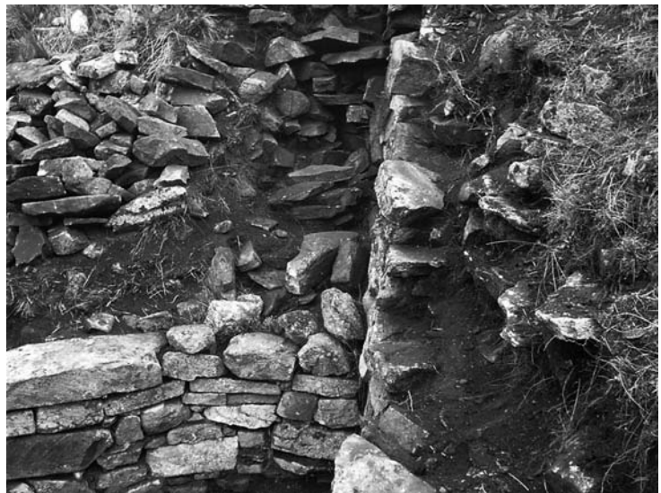
FIG. 7. Arranque del paramento del bastión.
