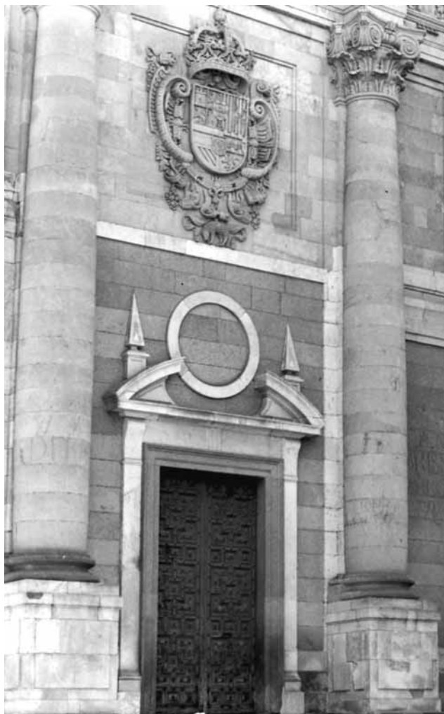
Figura 5. Portada principal de la Clero que combina la piedra vaugnerítica, de color más oscuro, con la arenisca dorada de Salamanca y el microconglomerado blanco del terciario.
