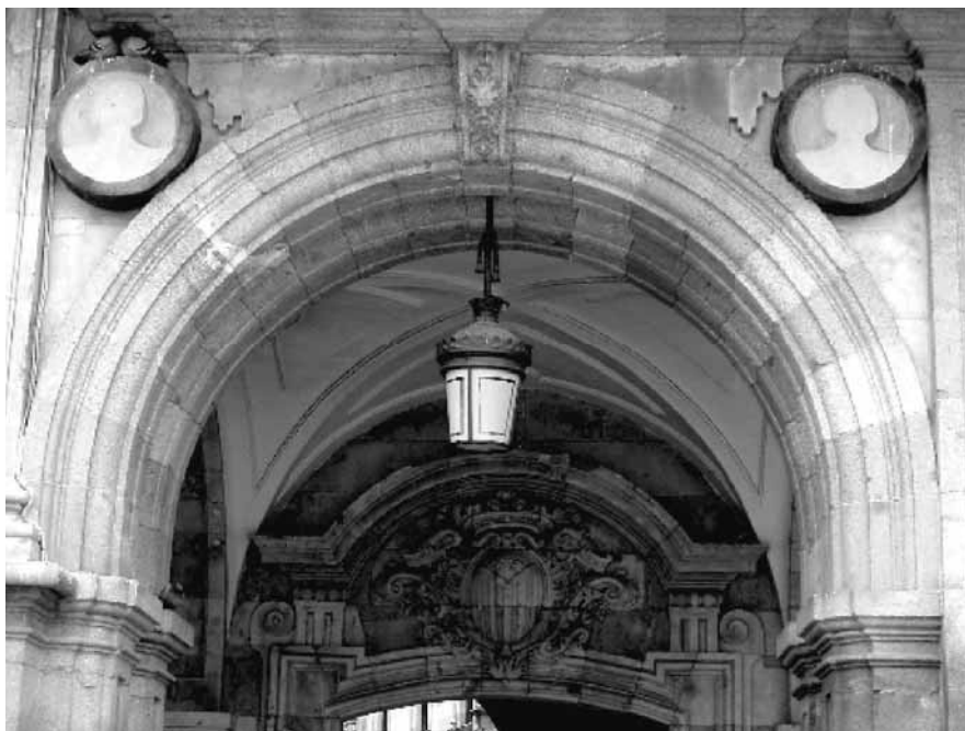
Figura 8. Detalle de uno de los arcos del pórtico del Ayuntamiento de Salamanca.
