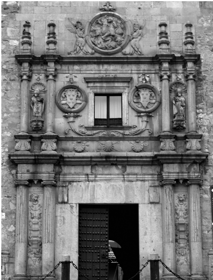
Figura 7. Fachada del Colegio de Fonseca.
