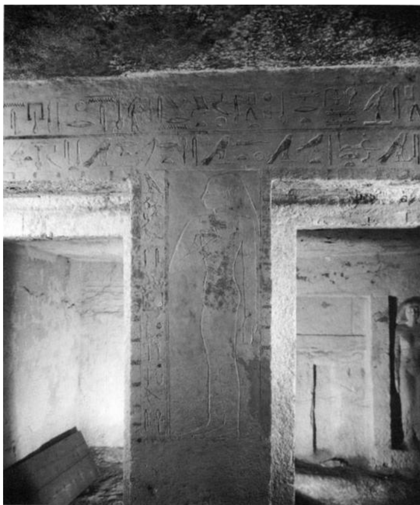
Figura 68.- Imagen de la pared oeste con dos aberturas que dan acceso a la sala oeste. (Tomada de: DUNHAM, D.; SIMPSON, W. K., 1974, Plate VII b).
